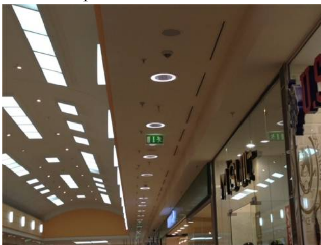
Фигура 9 Снимки от популярни вериги магазини с лошо изпълнено евакуационно осветление.
