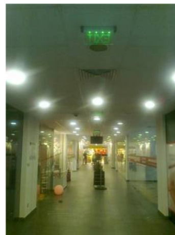
Фигура 9 Снимки от популярни вериги магазини с лошо изпълнено евакуационно осветление.
