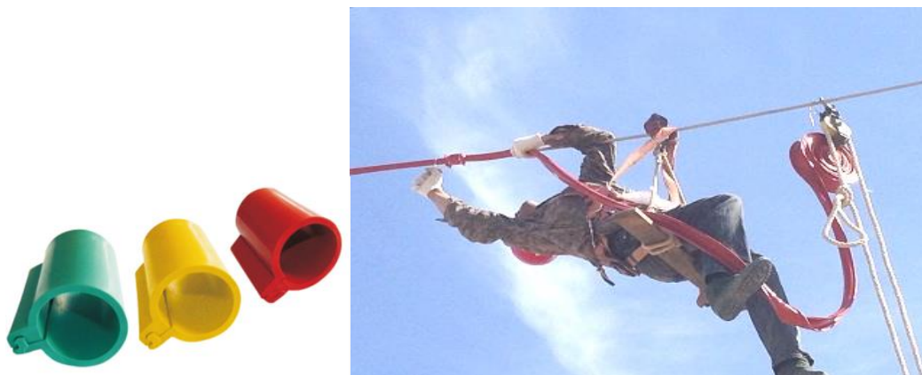
Фиг. 5. Общ вид и начин на монтаж на закопчаваша се тръба от силиконов каучук
